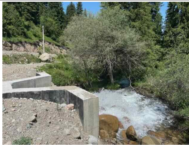
Photo 26: Tailrace discharge
