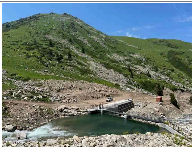
Фото 2: Территория головных сооружений ГЭС Боз-Учук
