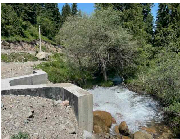
Фото 26: Выпуск отводящего канала
