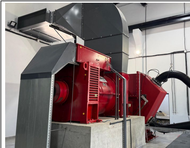
Фото 19: Внутренний вид здания ГЭС
