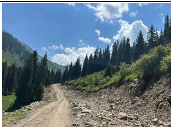
Фото 8: Улучшенная проектом дорога к водозабору; справа — напорный трубопровод
