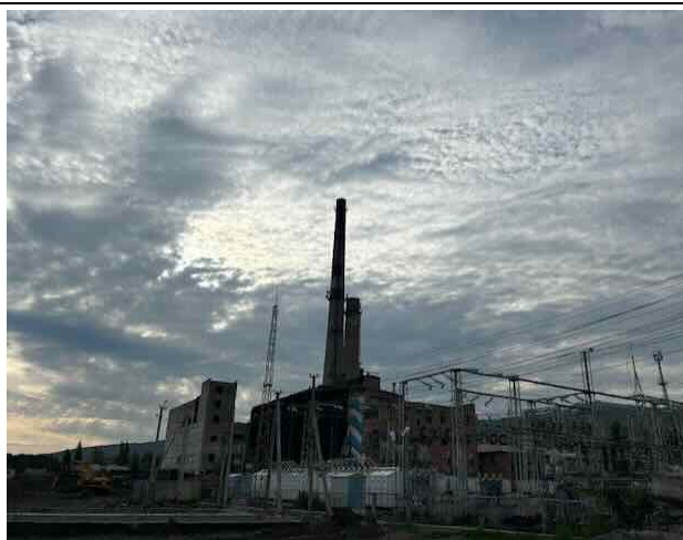
Фото 43: Неработающая угольная теплоэлектростанция в Караколе
