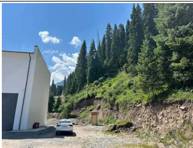
Фото 14: Территория справа от здания ГЭС с уборной; предстоит строительство подпорной стены
