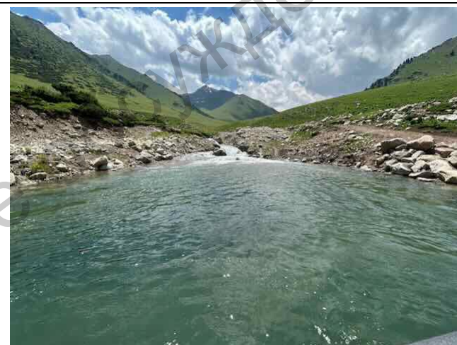
Фото 3: Водоприёмный бассейн, вид с плотины
