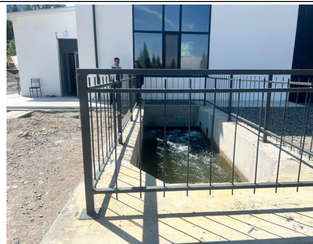
Фото 25: Отводящий канал здания ГЭС
